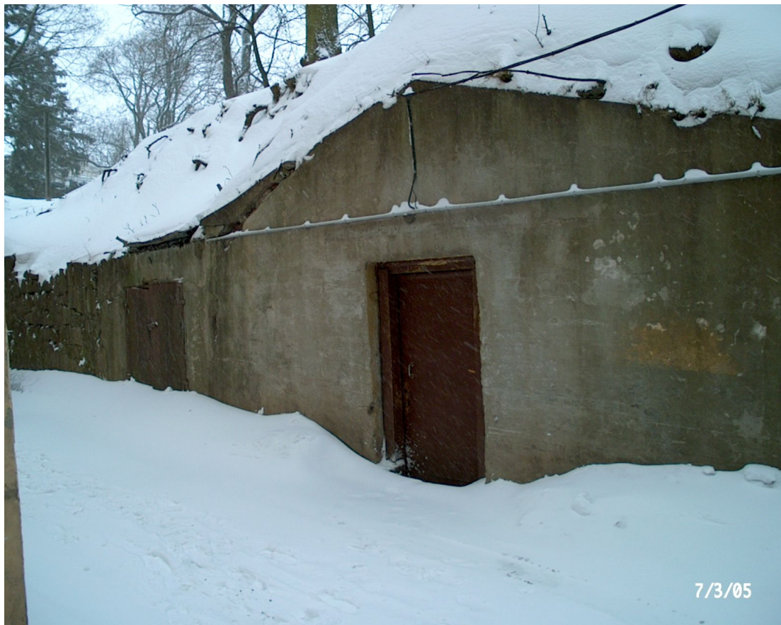
Foto 14. Poterni nr. 5 uks (foto keskel).
