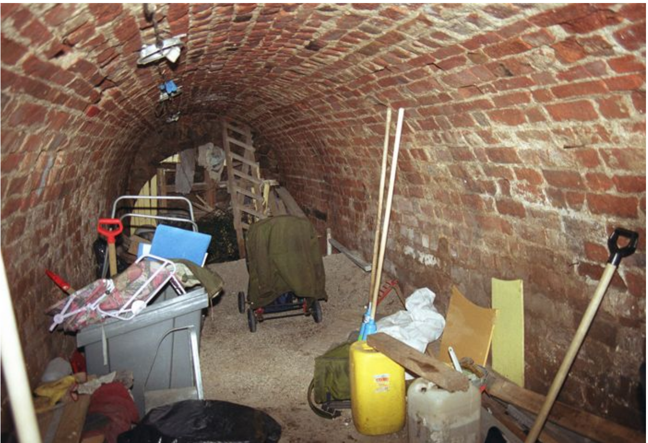
Foto 17. Poterni nr 6 sisevaade suunaga lõunasse maakividest müüri poole.
