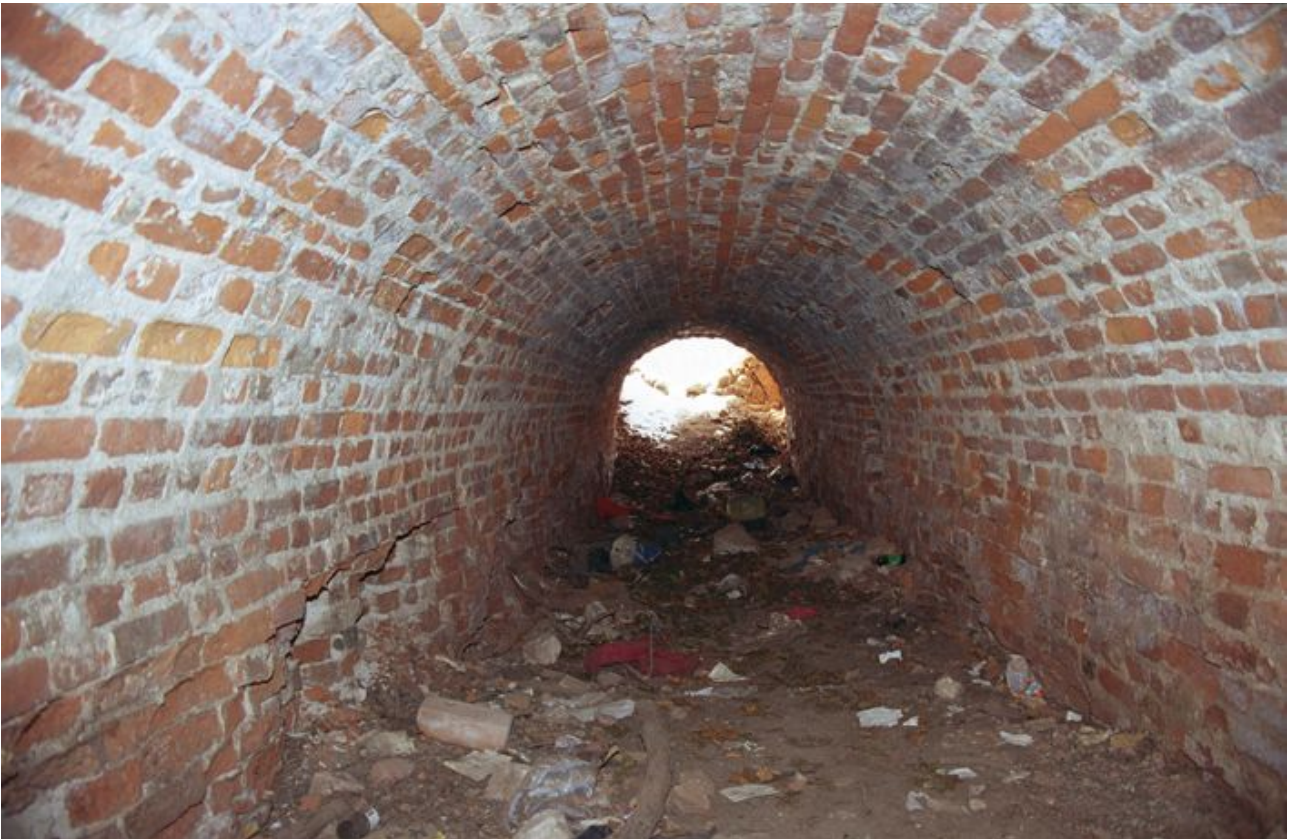
Foto 5. Poterni nr. 2 sisevaade suunaga läände.
