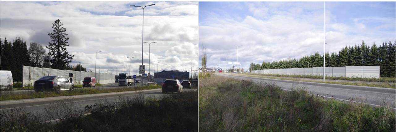
Müratõkkeseinad Tallinna-Tartu-Võru-Luhamaa tee ääres (Tartu linn, Tartu läänepoolse ümbersõidu II ehitusala)
