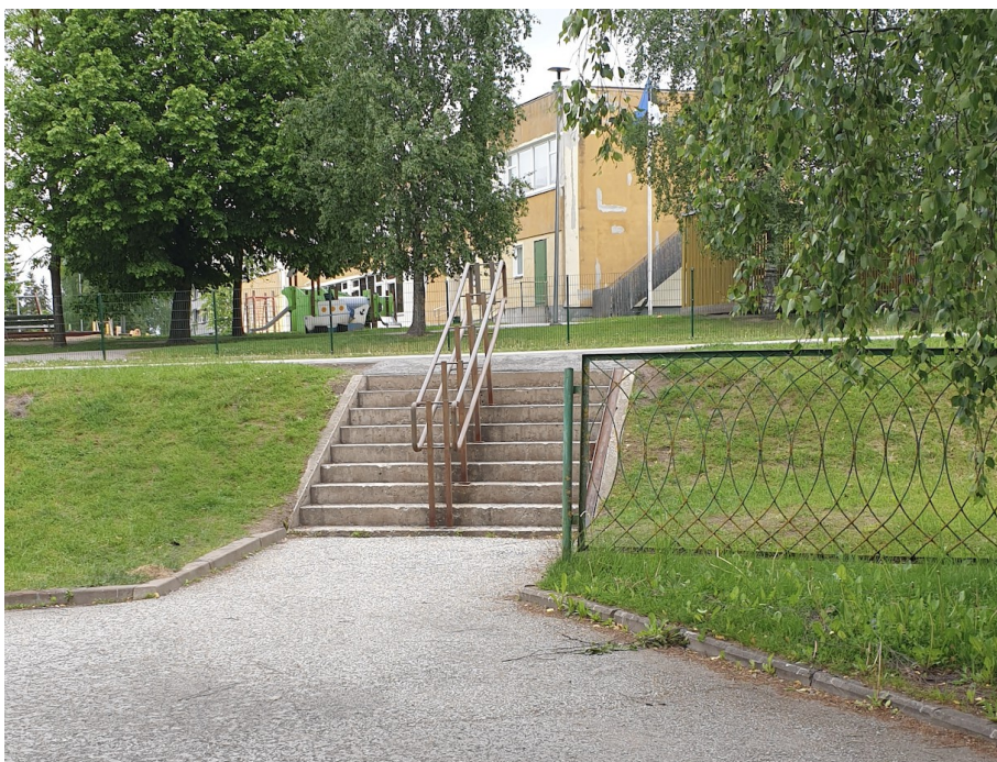
Foto nr 4. Järsk trepp ilma kaldteeta (Autori foto)
