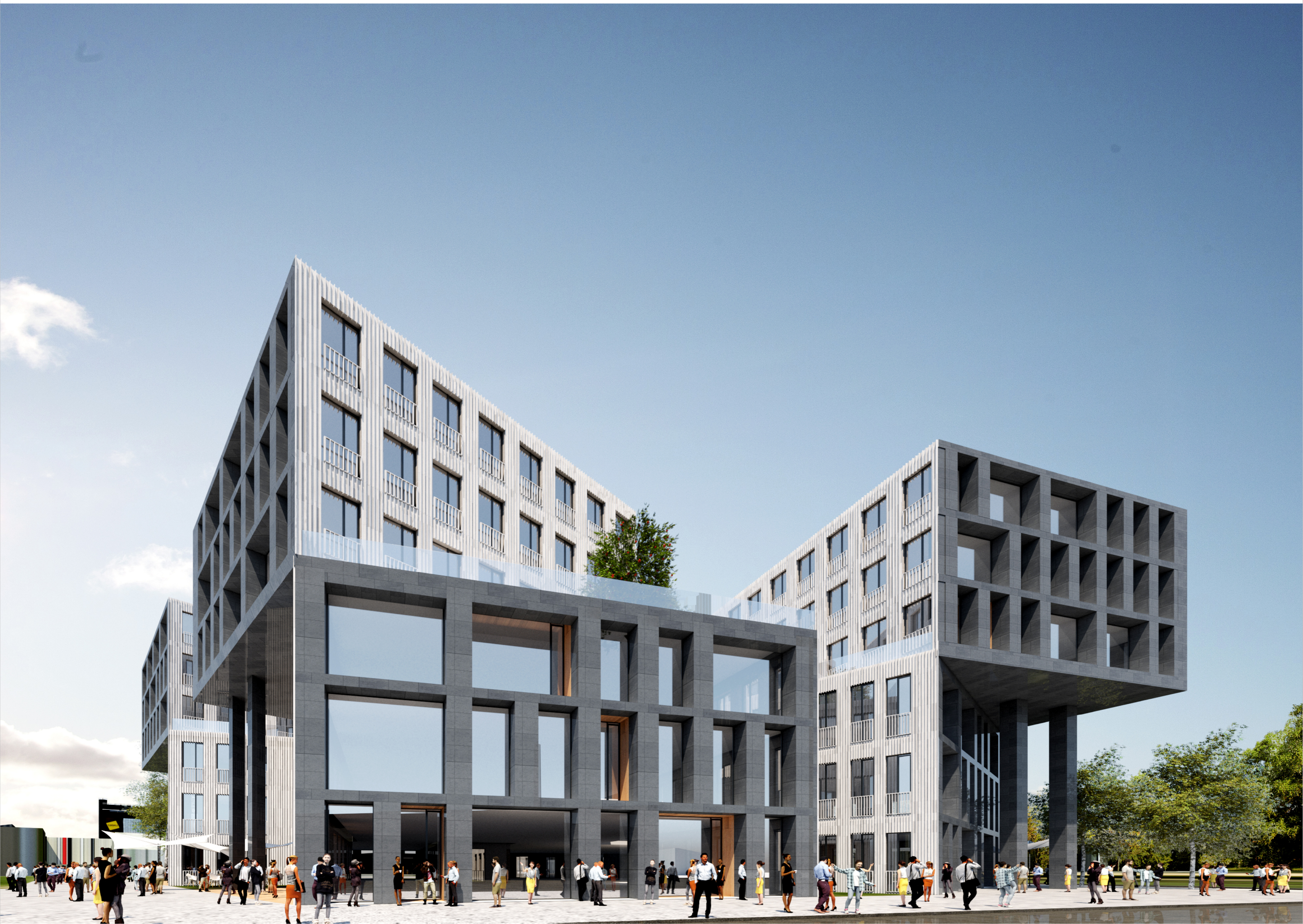
VAADE ZEPPELINI KESKUSE PARKLA POOLT PIKI JALAKÄIJATE TÄNAVAT
