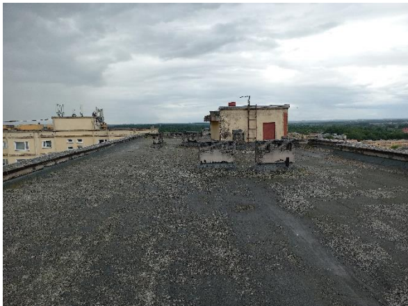
Joonis 2.3 Katuse olukord. Foto: Tamur Tensing / TREA 18.07.2022 a
