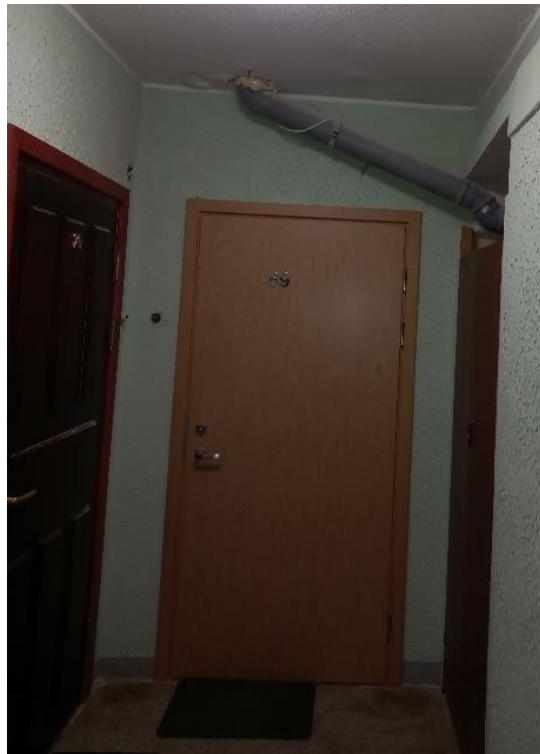
Joonis 2.9 Hoone sisene sadeveetorustik on välja vahetatud. Foto: Tamur Tensing / TREA 25.07.2022 a.
