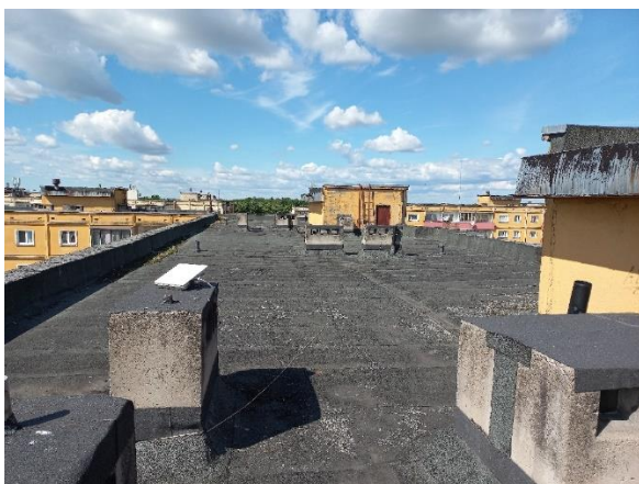
Joonis 2.4 Katuse olukord. Foto: Tamur Tensing / TREA 25.07.2022 a.
