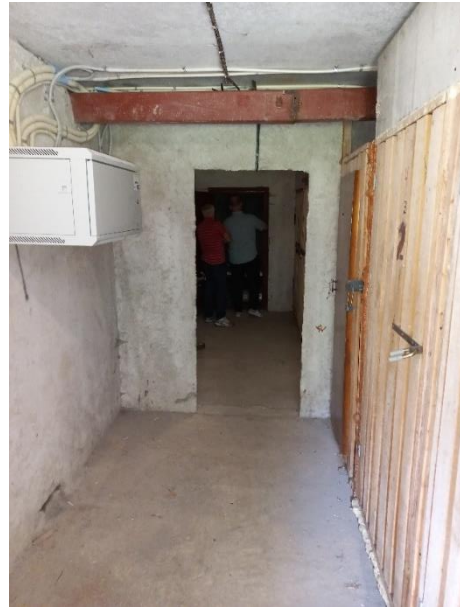
Joonis 2.9 Keldri vaade. Foto: Tamur Tensing / TREA 19.07.2022 a.
