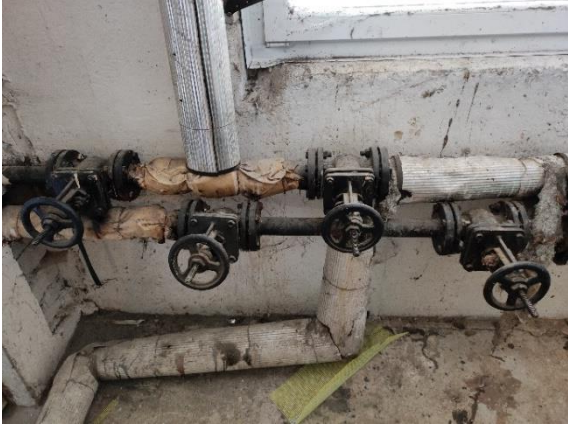
Joonis 2.6 Küttestorustike olukord. Foto: Martin Kikas / TREA 19.07.2022. a.
