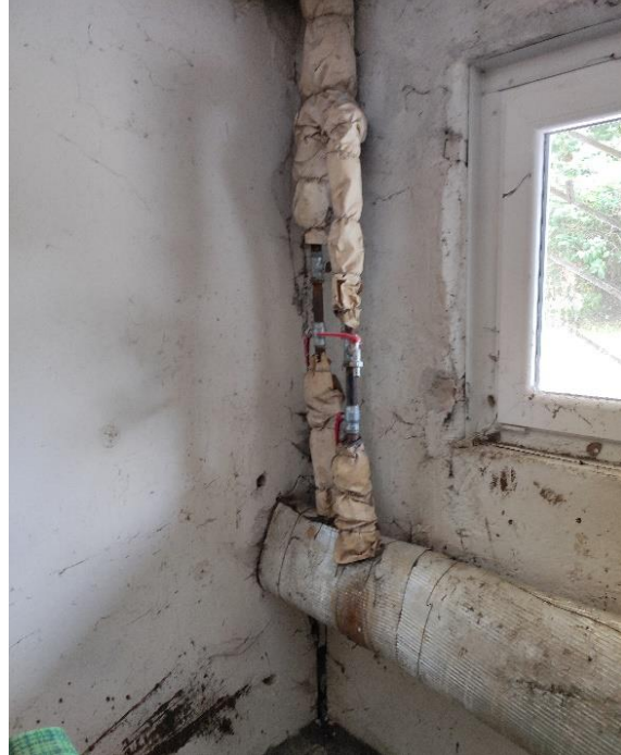
Joonis 2.7 Küttestorustike olukord. Foto: Martin Kikas / TREA 19.07.2022. a.
