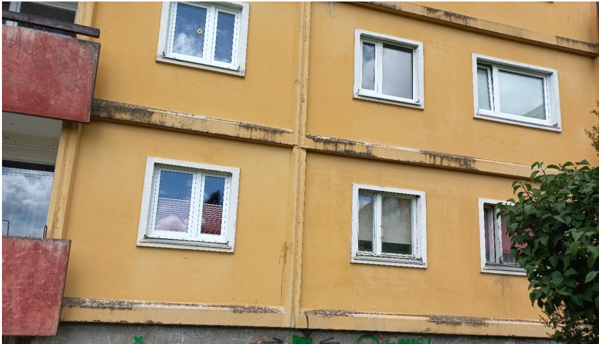
Joonis 2.2 Välisseina vuukide olukord. Foto: Tamur Tensing / TREA 19.07.2022 a
