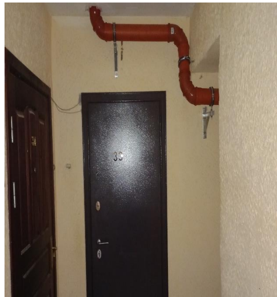
Joonis 2.10 Hoone sisene sadeveetorustik on välja vahetatud. Foto: Tamur Tensing / TREA 20.07.2022 a.
