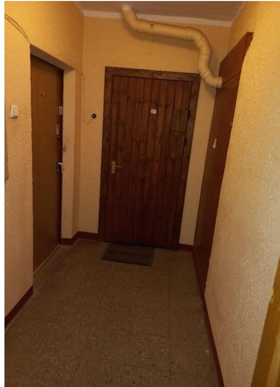
Joonis 2.13 Hoone sisene sadeveetorustik. Foto: Tamur Tensing / TREA 20.07.2022 a.
