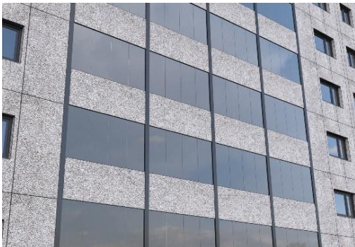
Joonis 3.8 Lodža hoonepoolse välisseina soojustamine ja avatavate lükandklaaside lisamine. Joonis on illustratiivne. Teostaja: OÜ 3D-PILT 18.08.2022
