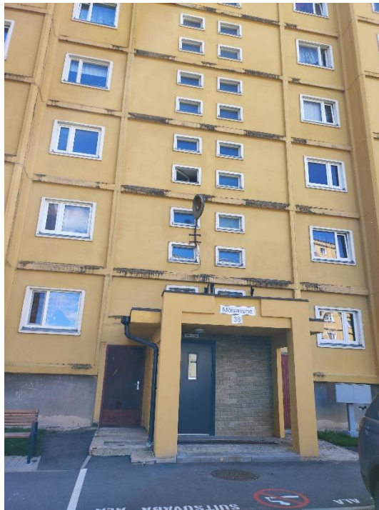
Joonis 2.9 Tuulekoja olukord. Foto: Martin Kikas / TREA 20.07.2022 a.
