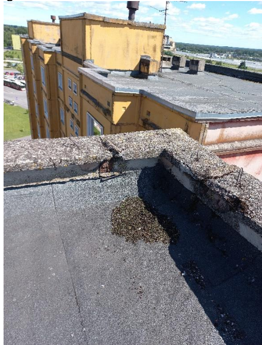
Joonis 2.8 Katuse olukord. Foto: Tamur Tensing / TREA 20.07.2022 a.
