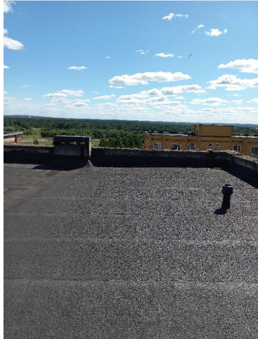
Joonis 2.6 Katuse olukord. Foto: Tamur Tensing / TREA 20.07.2022 a.
