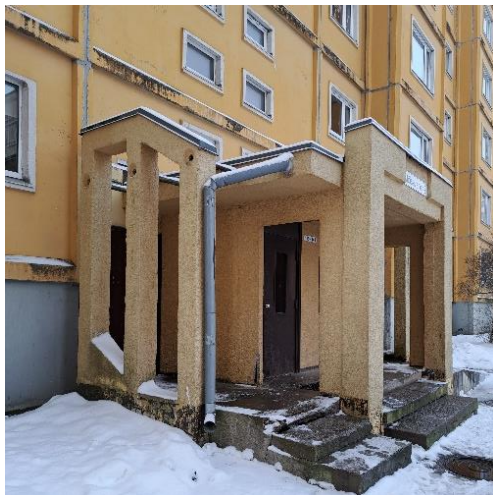
Joonis 2.5 Tuulekoja olukord. Foto: Gerli Alasoo / TREA 30.11.2022 a
