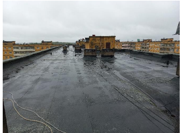
Joonis 2.4 Katuse olukord. Foto: Tamur Tensing / TREA 01.08.2022 a
