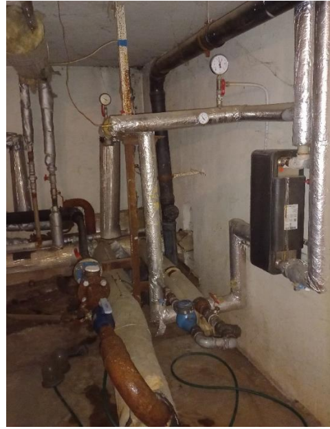
Joonis 2.9 Soojussõlme olukord. Foto: Tamur Tensing / TREA 01.08.2022 a.
