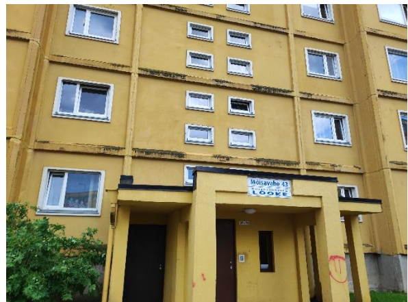
Joonis 2.4 Tuulekoja olukord. Foto: Martin Kikas / TREA 19.07.2022 a
