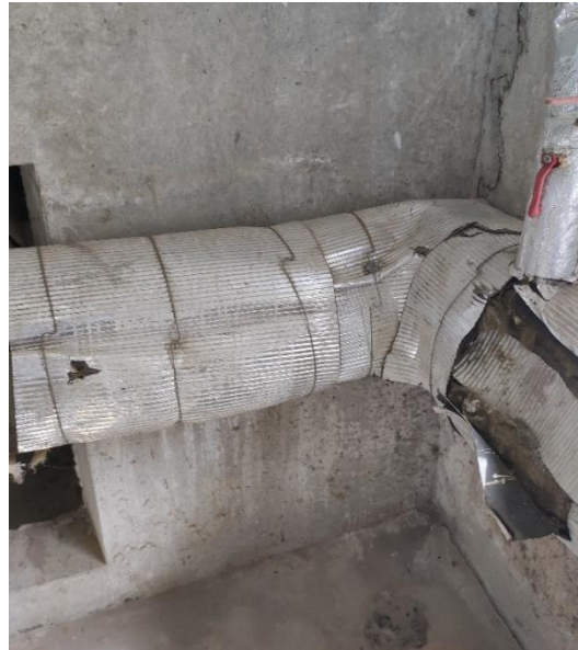
Joonis 2.7 Küttestorustike olukord. Foto: Martin Kikas / TREA 19.07.2022. a
