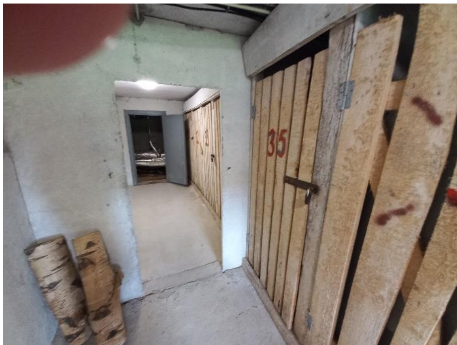
Joonis 2.8 Keldri vaade. Foto: Tamur Tensing / TREA 19.07.2022 a
