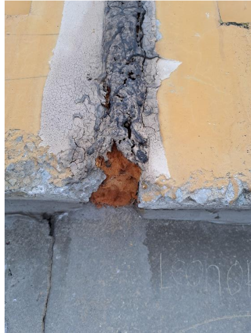
Joonis 2.3 Otsaseina vuukide olukord. Foto: Gerli Alasoo / TREA 30.11.2022 a.
