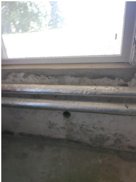
Joonis 2.9 Kütetorustike olukord. Foto: Martin Kikas / TREA 14.07.2022. a
