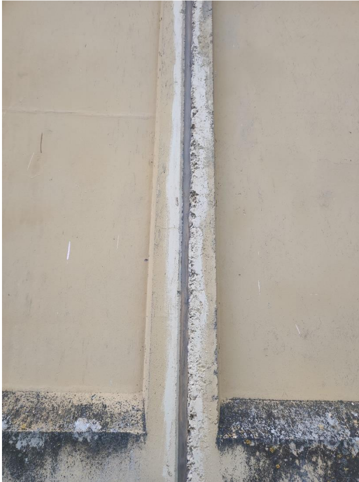
Joonis 2.2 Välisseina vuukide olukord. Foto: Martin Kikas / TREA 19.07.2022 a
