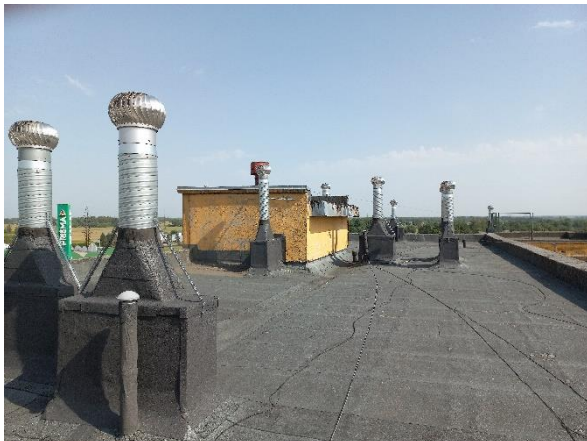
Joonis 2.3 Katuse olukord. Foto: Tamur Tensing / TREA 19.07.2022 a
