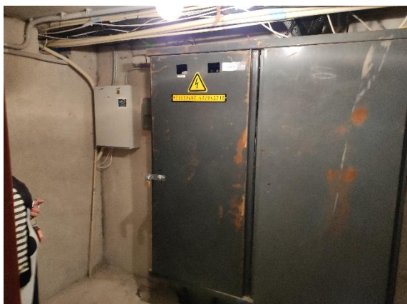
Joonis 2.10 Elektrikilbi ruum. Foto Martin Kikas / TREA 19.07.2022. a
