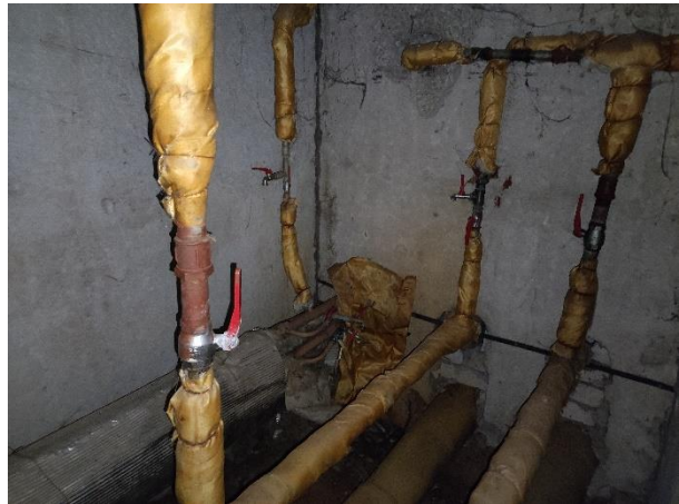
Joonis 2.8 Kütetorustike olukord. Foto: Martin Kikas / TREA 15.07.2022. a
