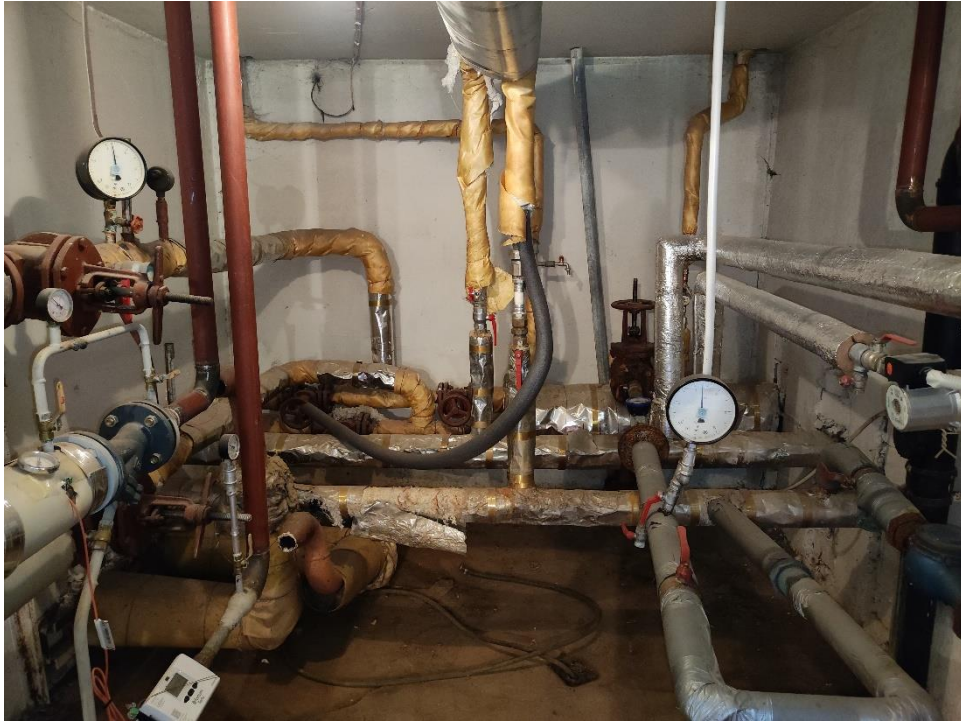
Joonis 2.6 Soojussõlme olukord. Foto: Martin Kikas / TREA 15.07.2022 a
