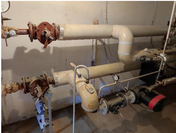
Joonis 2.7 Kütetorustike olukord. Foto: Martin Kikas / TREA 15.07.2022. a
