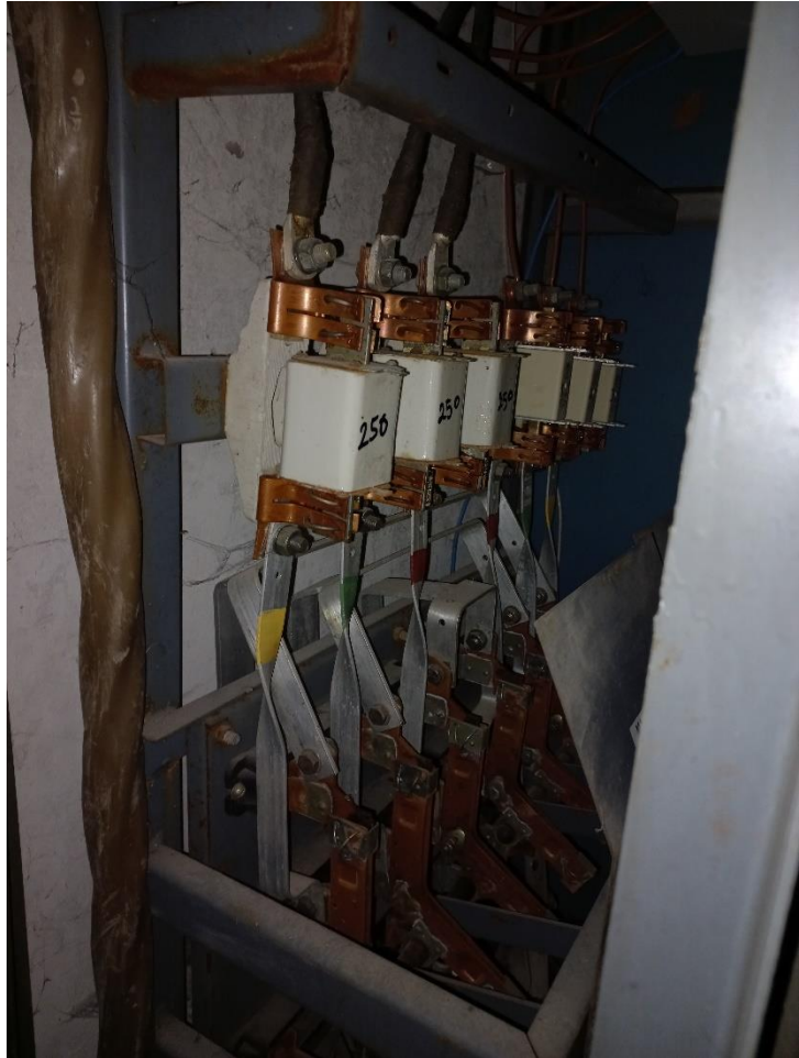
Joonis 2.10 Peakaitse. Foto Tamur Tensing / TREA 15.07.2022. a
