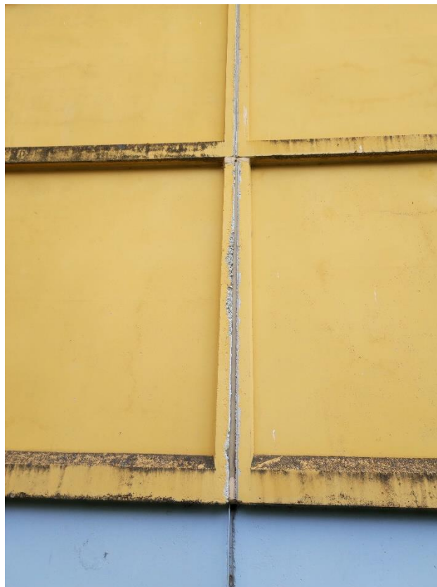
Joonis 2.2 Välisseina vuukide olukord. Foto: Martin Kikas / TREA 15.07.2022 a
